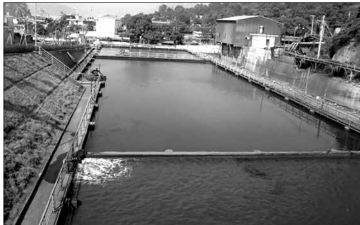
▲ Trạm xử lý nước thải mỏ hầm lò Núi Nhện 1.200 m 3 /h, TP. Cẩm Phả, Quảng Ninh do Công ty VTTE tư vấn và thiết kế
